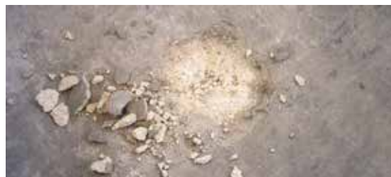
Superficie arenosa de baja calidad
