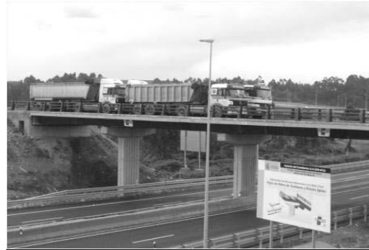
Figura 5.- Fotografía del Ensayo de Carga Estática.
