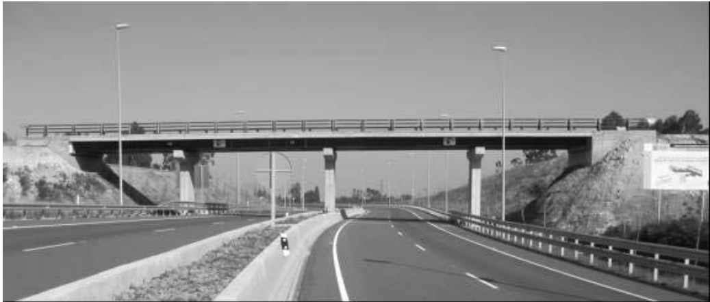
Figura 3.- Vista General del Paso Superior de la Autovía del Cantábrico (Necso).
