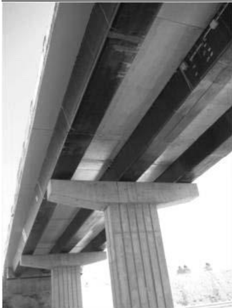
Figura 4.- Detalle de las vigas de fibra de carbono.
